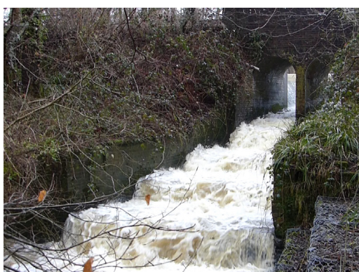
Balcombe Lake weir
